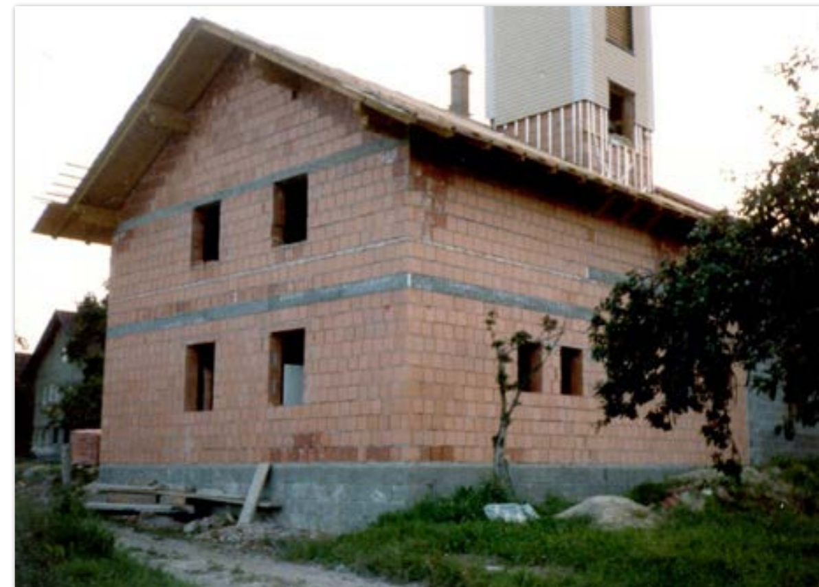
Abbildung 63: Rohbau des neuen Zeughauses, 1993 117
